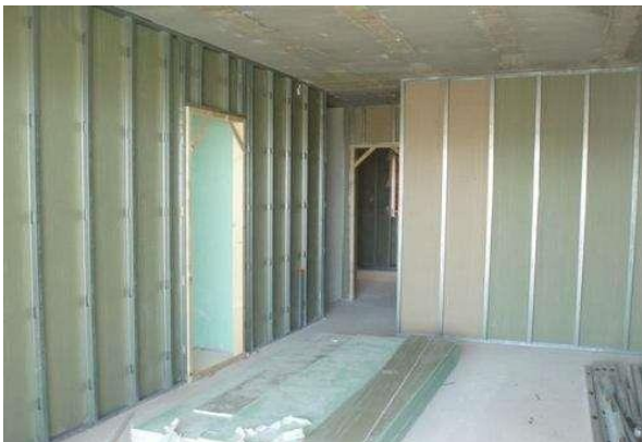
Muros de sheet-rock
