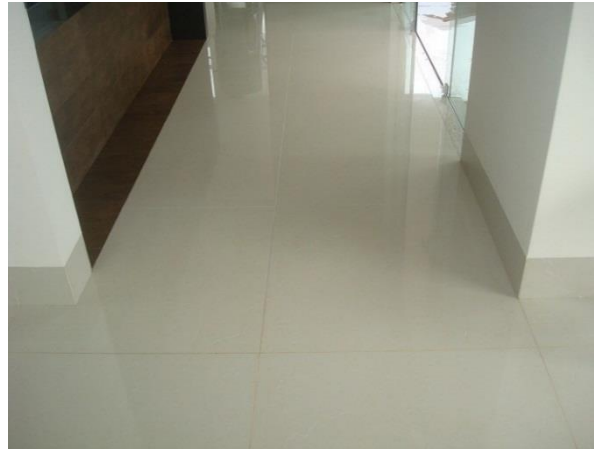
Porcelanato y derretido de juntas
