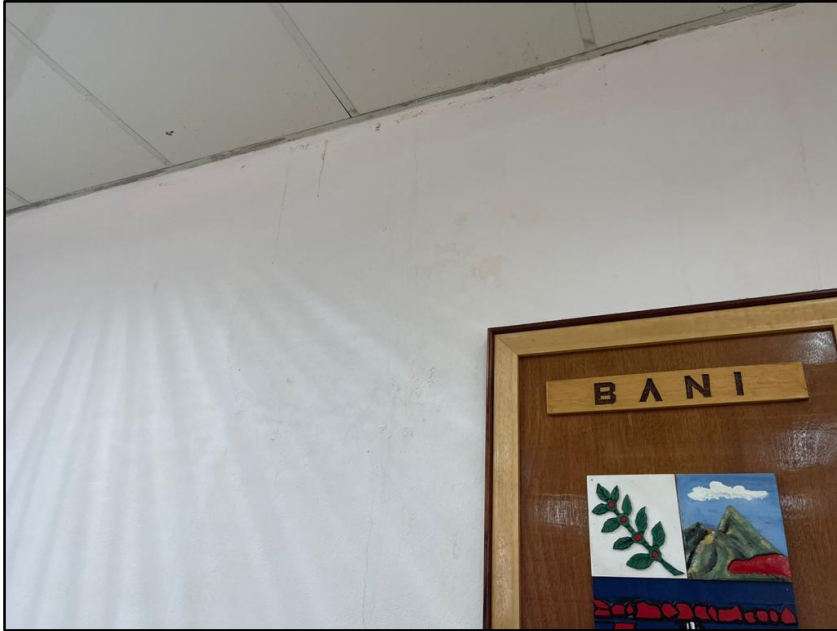
Pared con filtraciones
