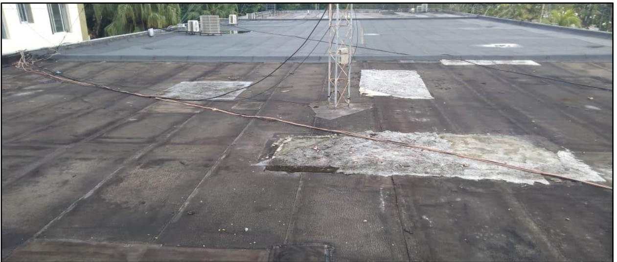
Lona asfáltica deteriorada
