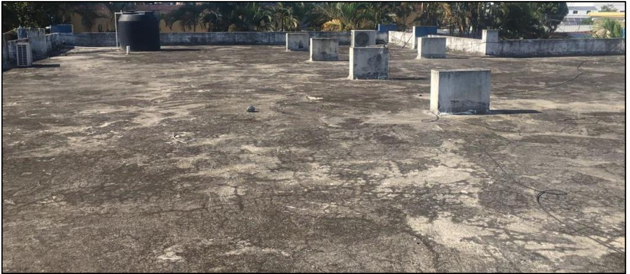
Techo sin impermeabilizante
