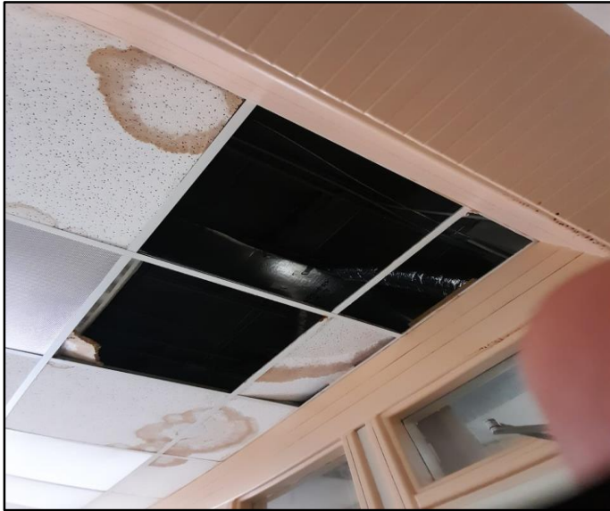
Plafones deteriorado por incidencia del agua
