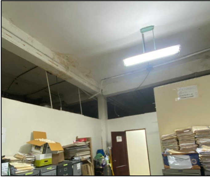
Techo área legajos con manchas de filtraciones
