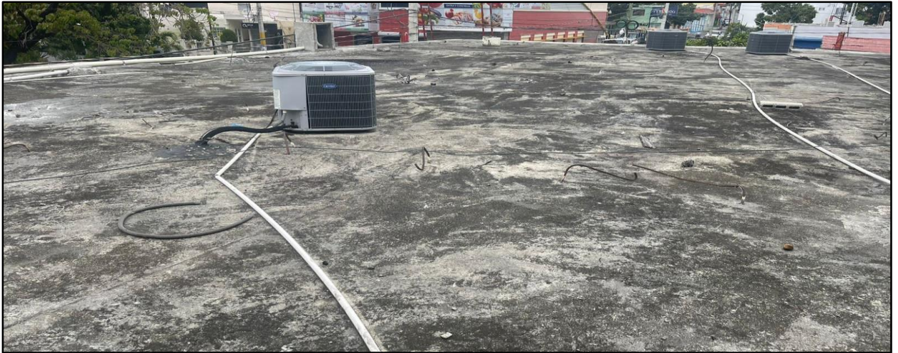
Techo sin impermeabilizante
