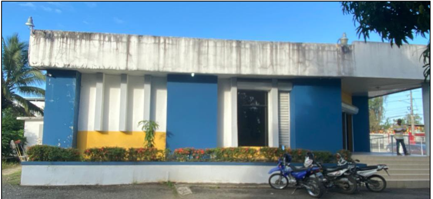
Antepecho deteriorado por filtraciones
