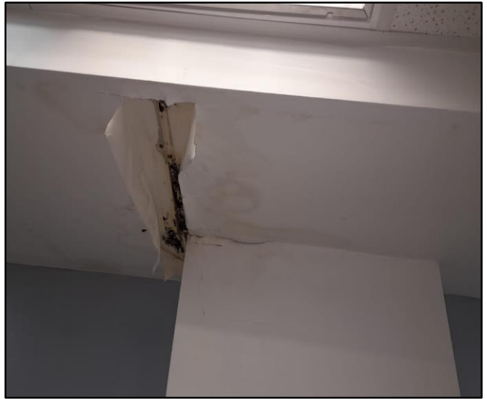
Sheetrock deteriorado por incidencia del agua
