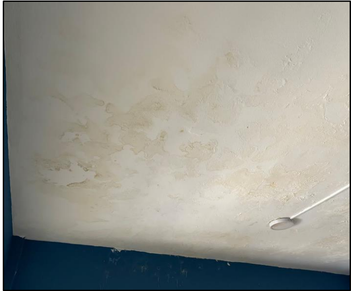
Techo con machas de filtraciones
