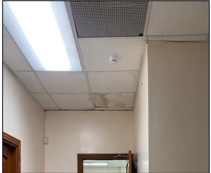
Plafones deteriorado por incidencia del agua
