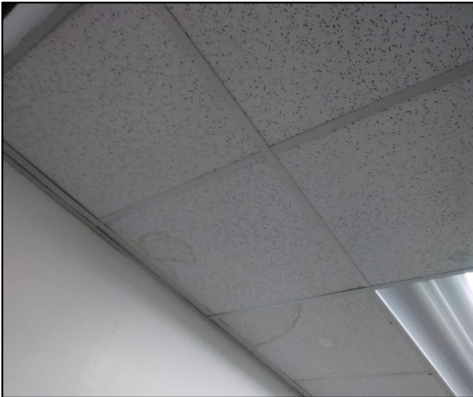
Plafones deteriorado por incidencia del agua
