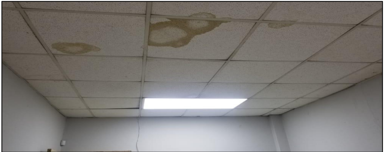
Plafones deteriorado por incidencia del agua
