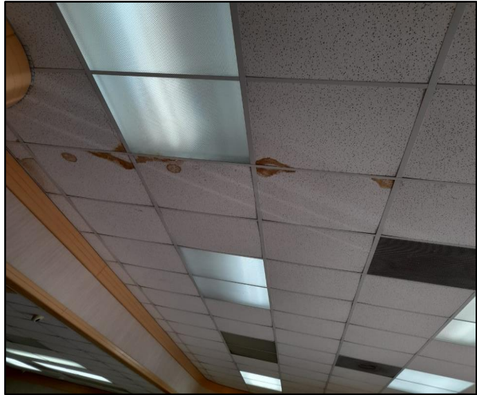
Plafones deteriorado por incidencia del agua
