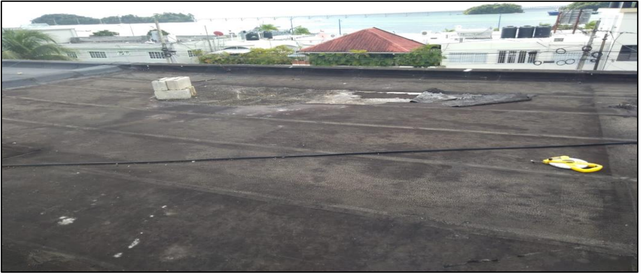
Lona asfáltica deteriorada
