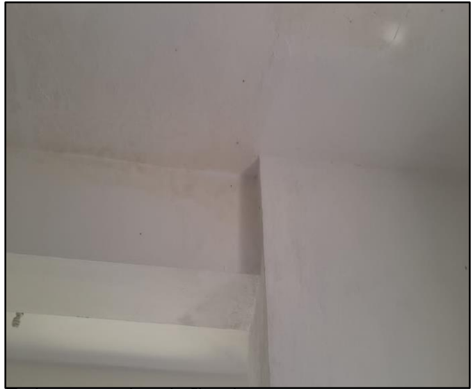
Techo con manchas de filtraciones
