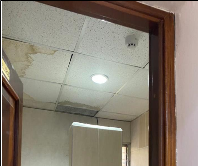
Plafones deteriorado por incidencia del agua
