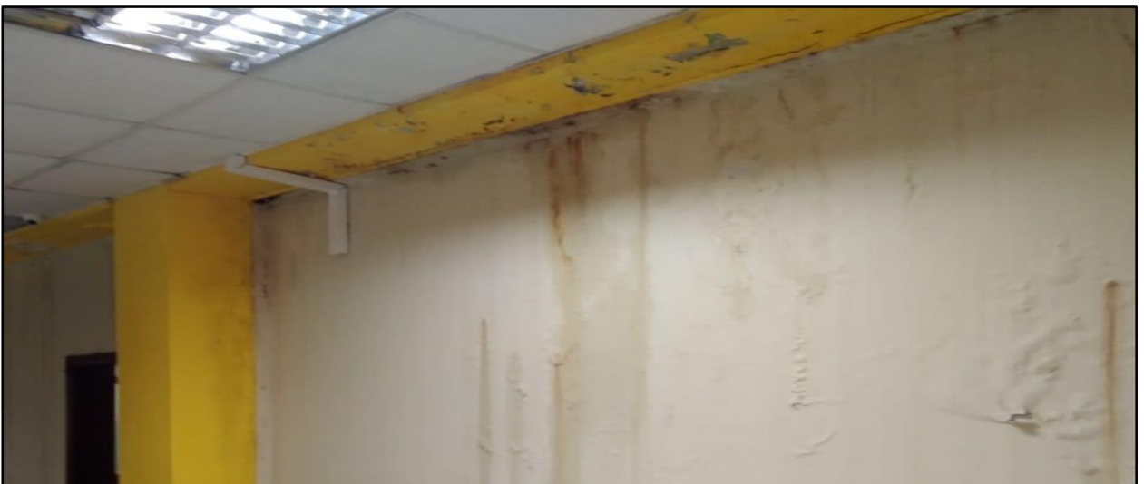
Pared y techo afectados por filtraciones
