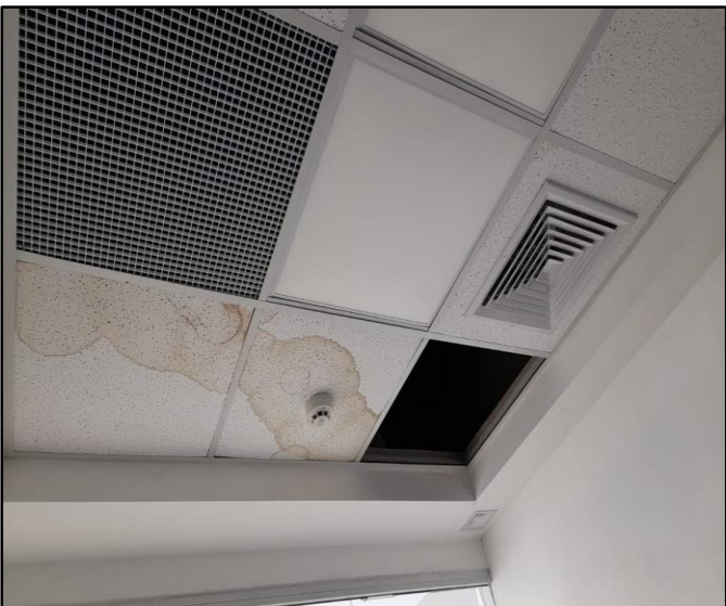
Plafones deteriorado por incidencia del agua
