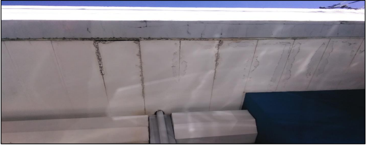
Plafones PVC deteriorados por filtraciones
