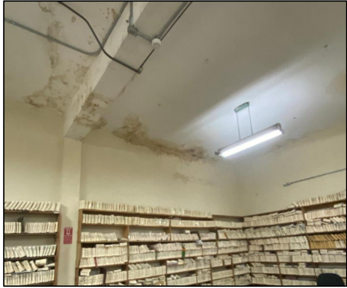
Techo área archivos con manchas de filtraciones
