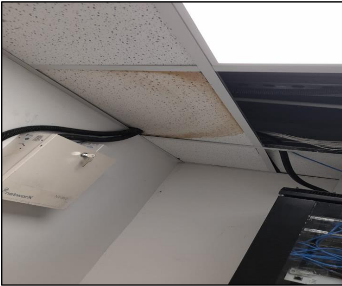
Plafones deteriorado por incidencia del agua
