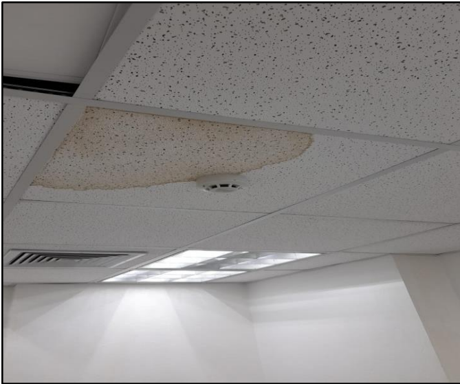
Plafones deteriorado por incidencia del agua
