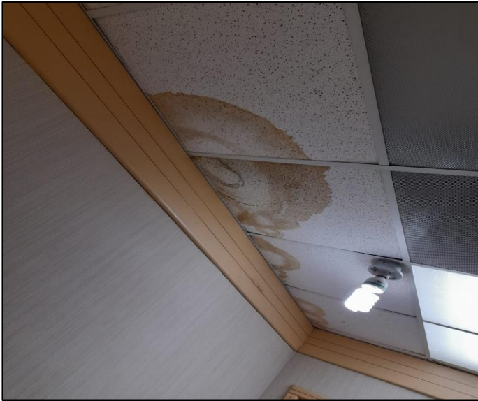
Plafones deteriorado por incidencia del agua
