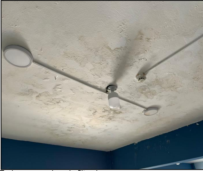
Techo con machas de filtraciones
