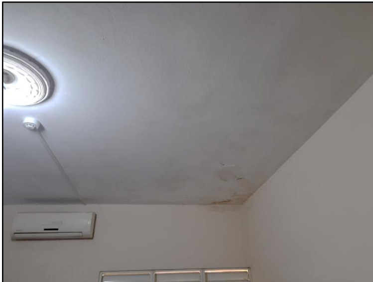
Techo con daños por agua
