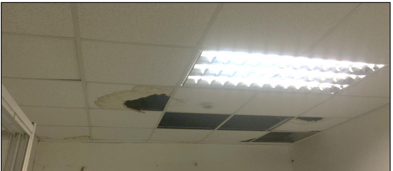
Plafón deteriorado por incidencia del agua
