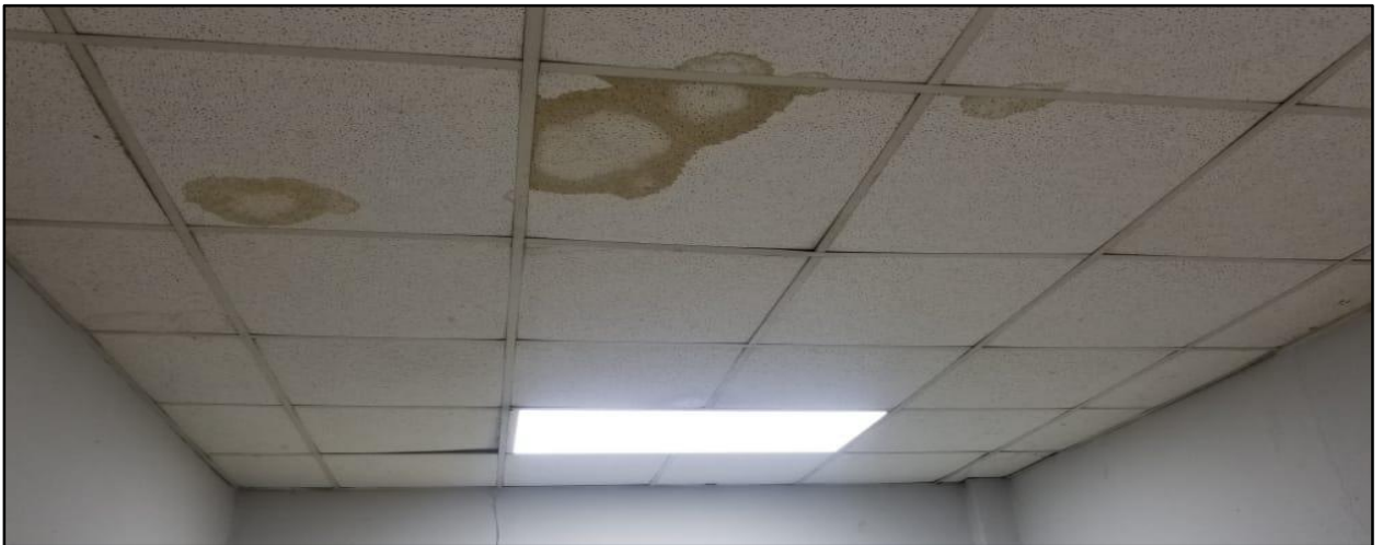
Plafones deteriorado por incidencia del agua
