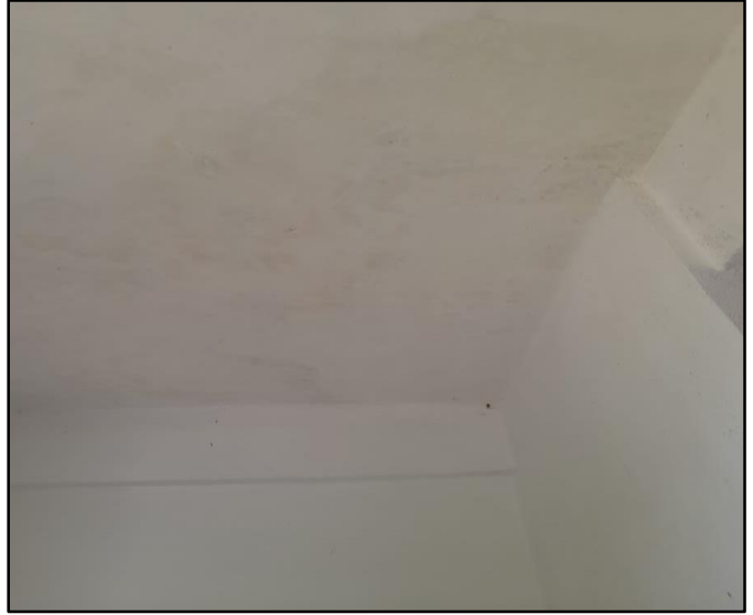
Techo con manchas de filtraciones
