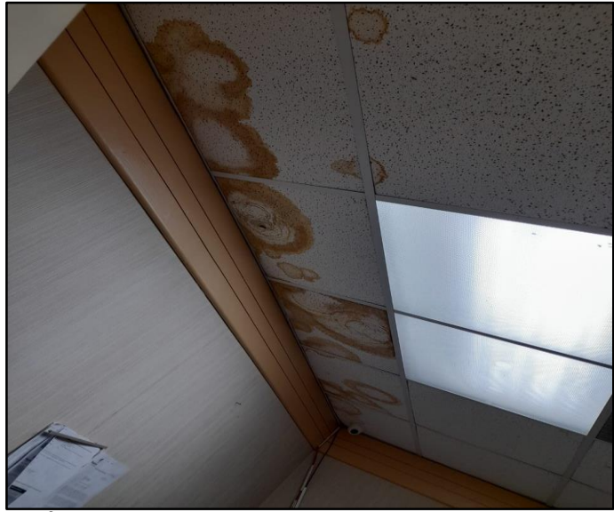
Plafones deteriorado por incidencia del agua
