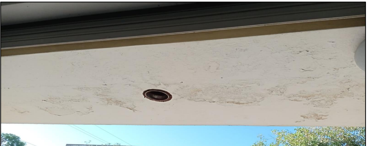
Techo con machas de filtraciones
