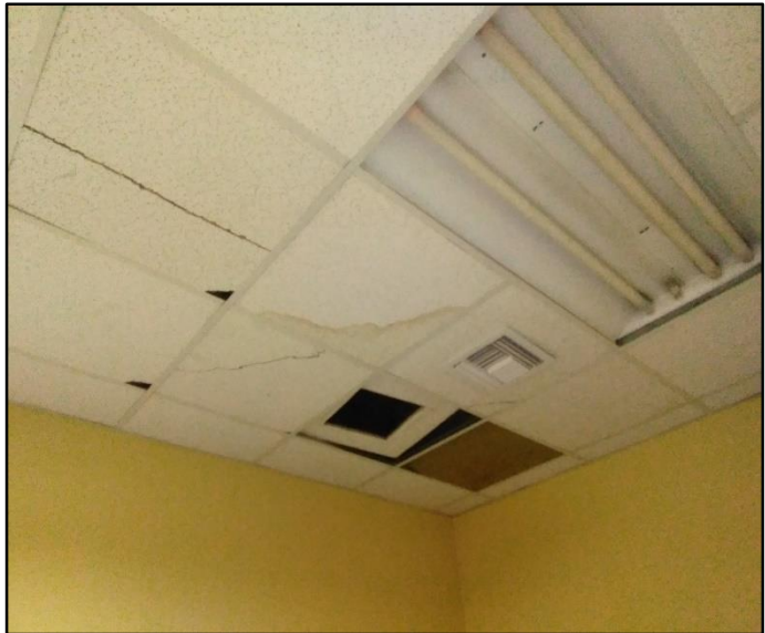
Plafones deteriorado por incidencia del agua
