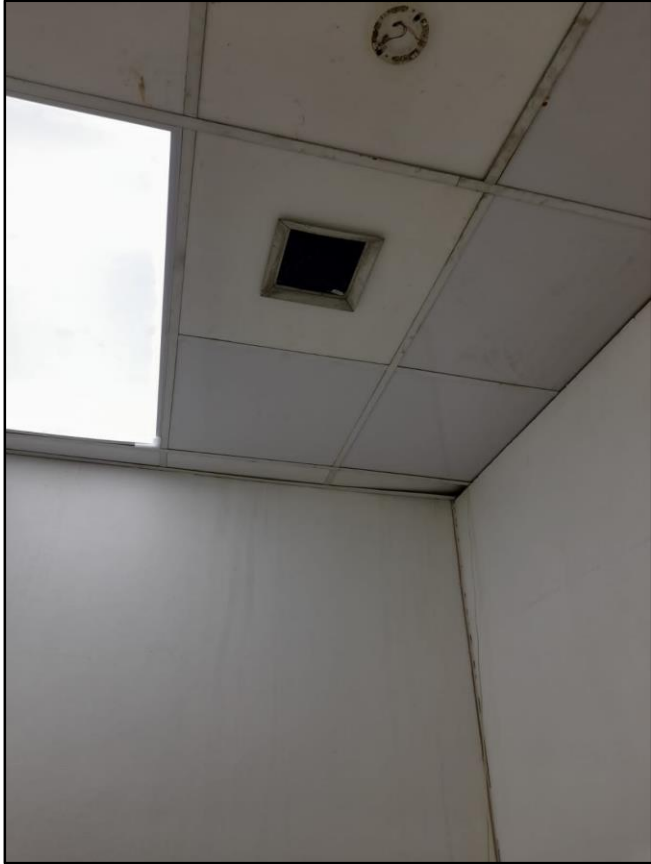
Plafón PVC deteriorado a reemplazar
