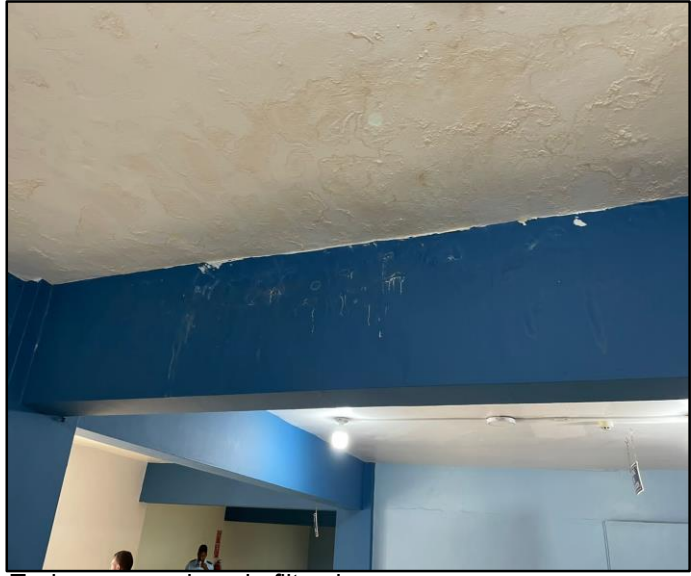
Techo con machas de filtraciones
