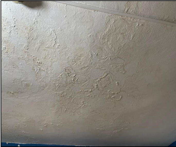
Techo con machas de filtraciones
