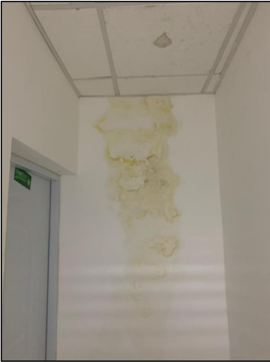
Pared manchada por agua
