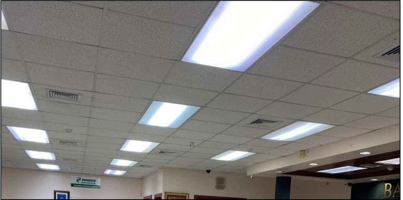
Lámparas fluorescentes a reemplazar por paneles led
