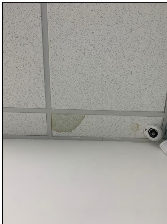
Plafones deteriorado por incidencia del agua
