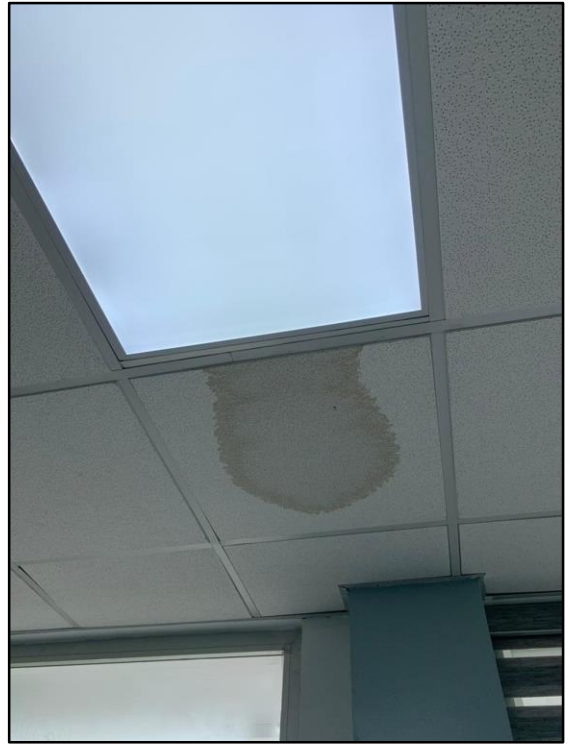
Plafones deteriorado por incidencia del agua
