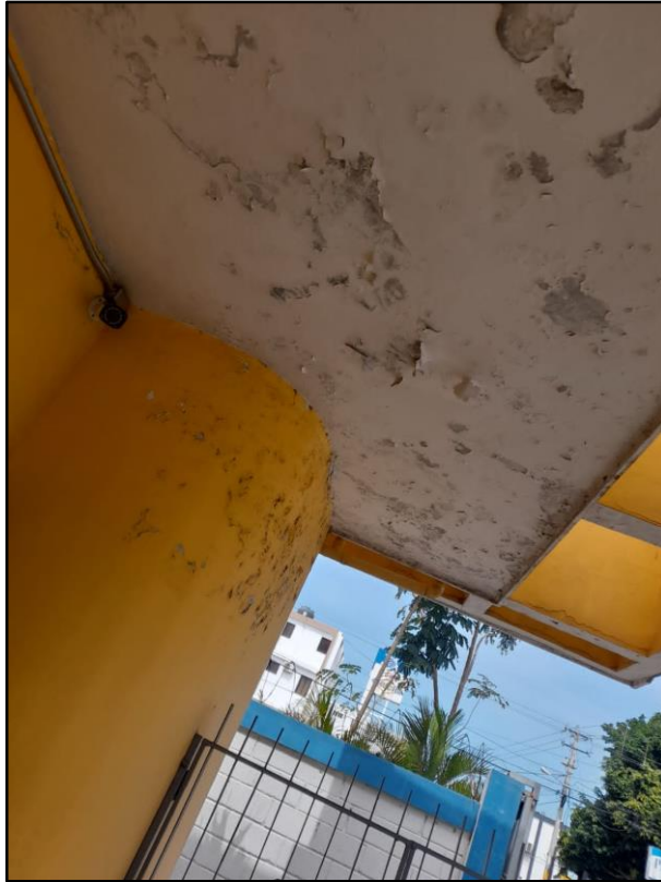
Techo con daños por agua
