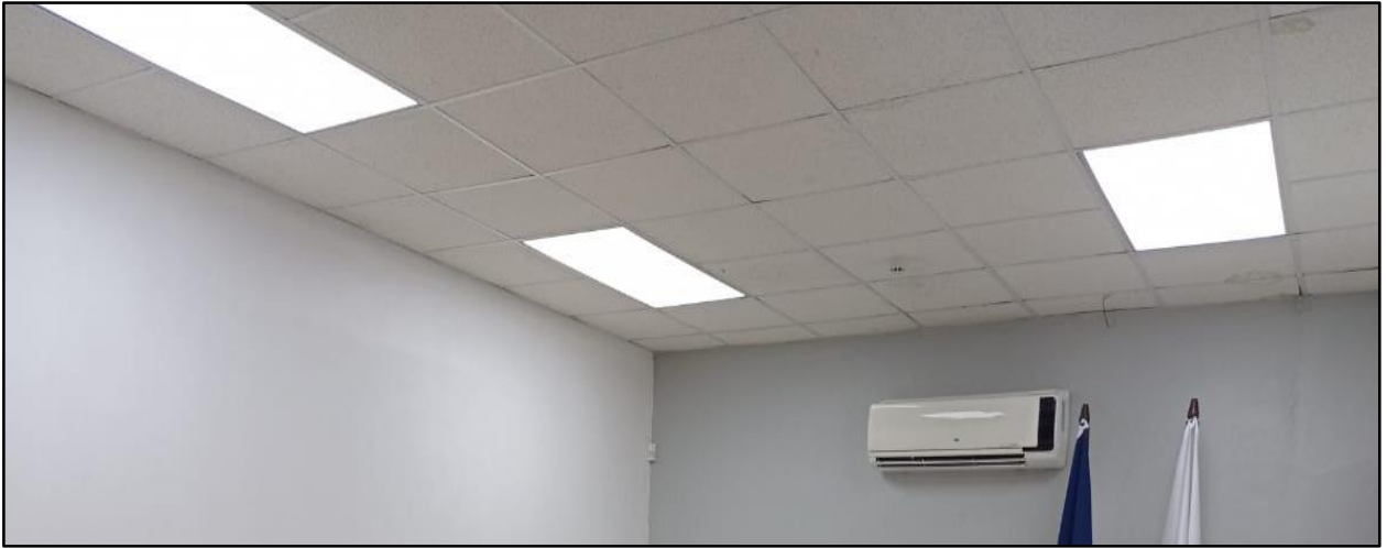
Plafón con aspecto deplorable
