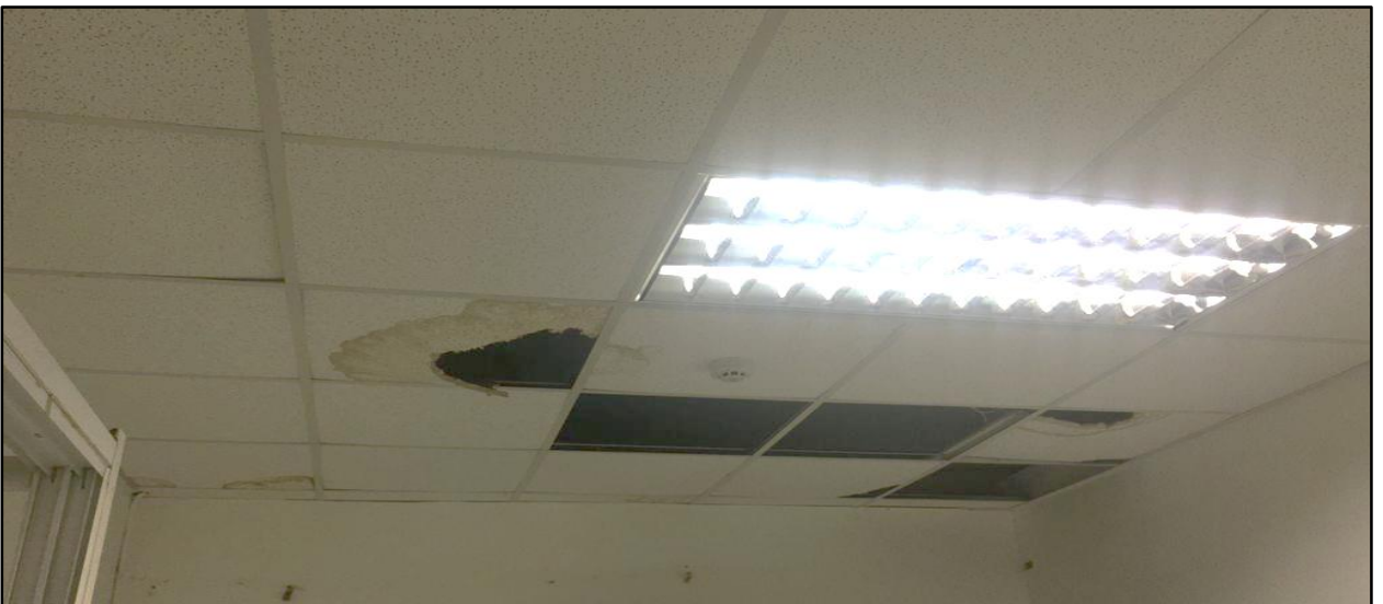
Plafón deteriorado por incidencia del agua
