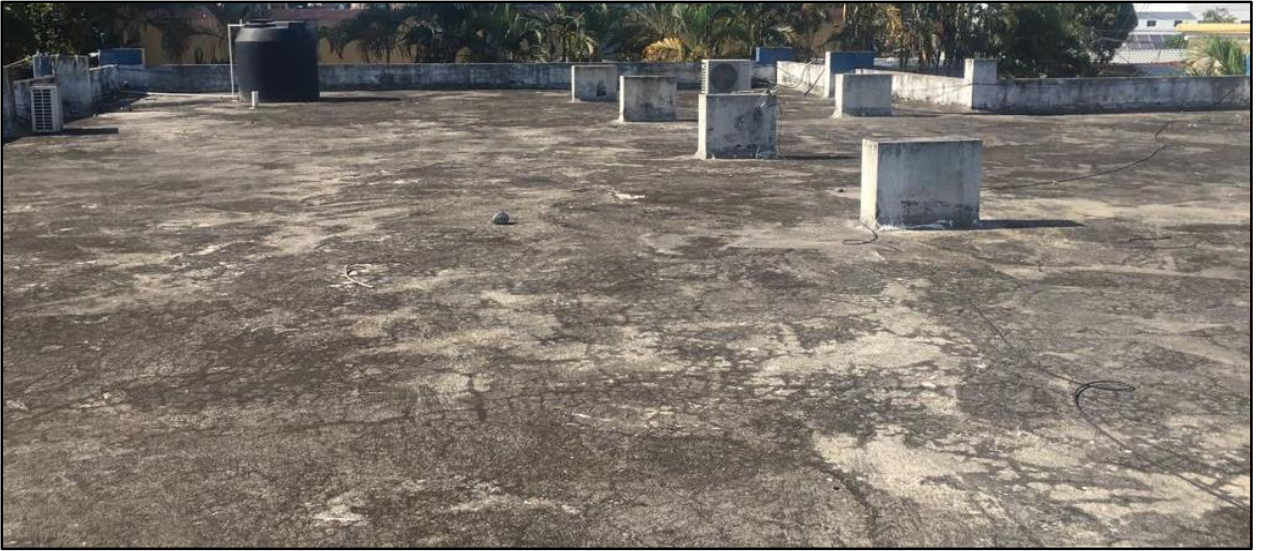
Techo sin impermeabilizante
