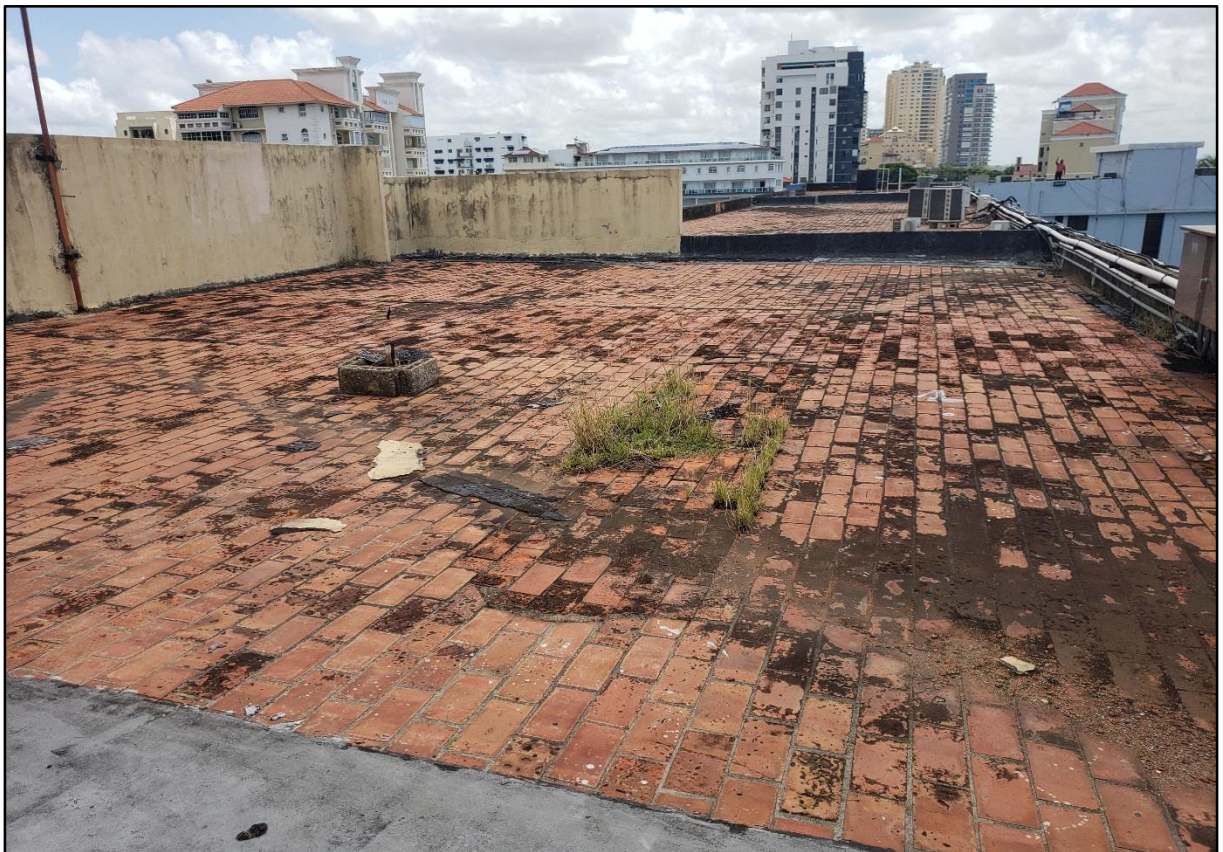
2-FINO DE TECHO CON ALTO DETERIORO (LOBBY INDEPENDENCIA)
