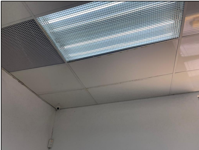
Lámpara fluorescente y plafón PVC a reemplazar
