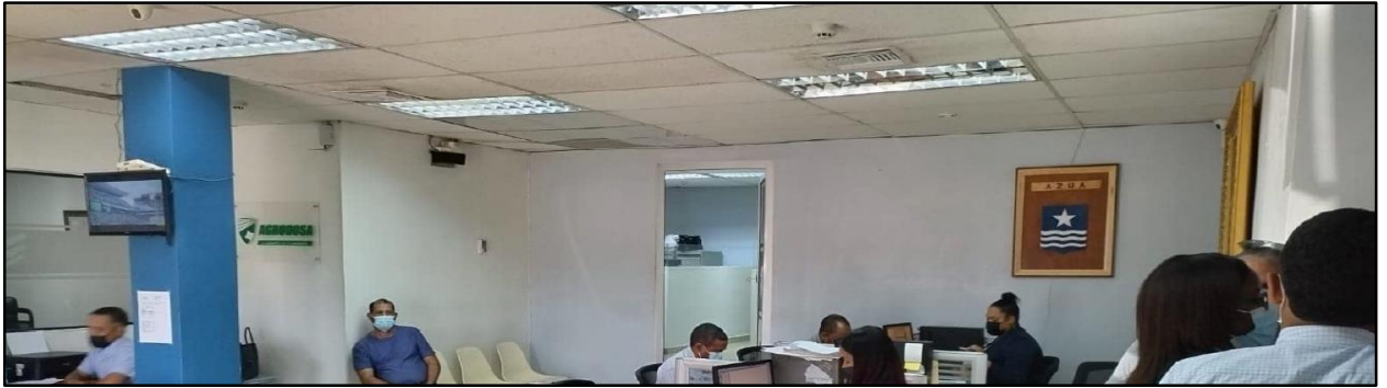
Plafón con aspecto deplorable
