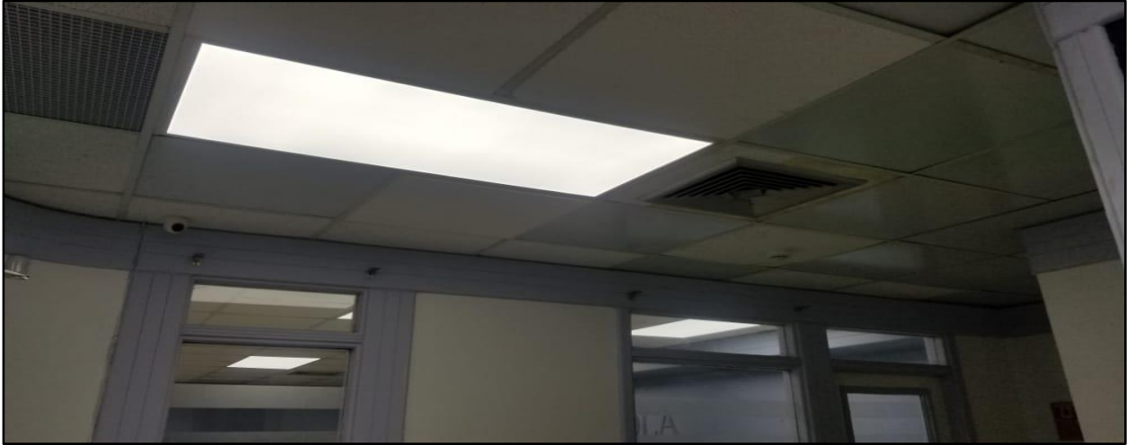
Plafones PVC a sustituir / Lámpara con poca iluminación
