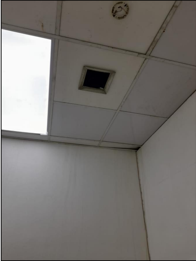
Plafón PVC deteriorado a reemplazar
