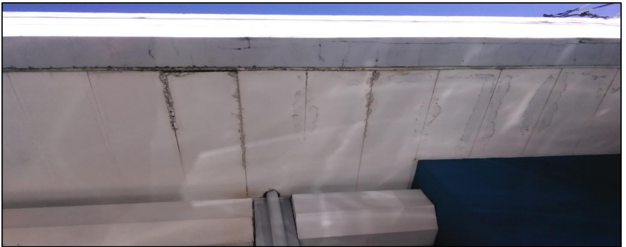
Plafones PVC deteriorados por filtraciones
